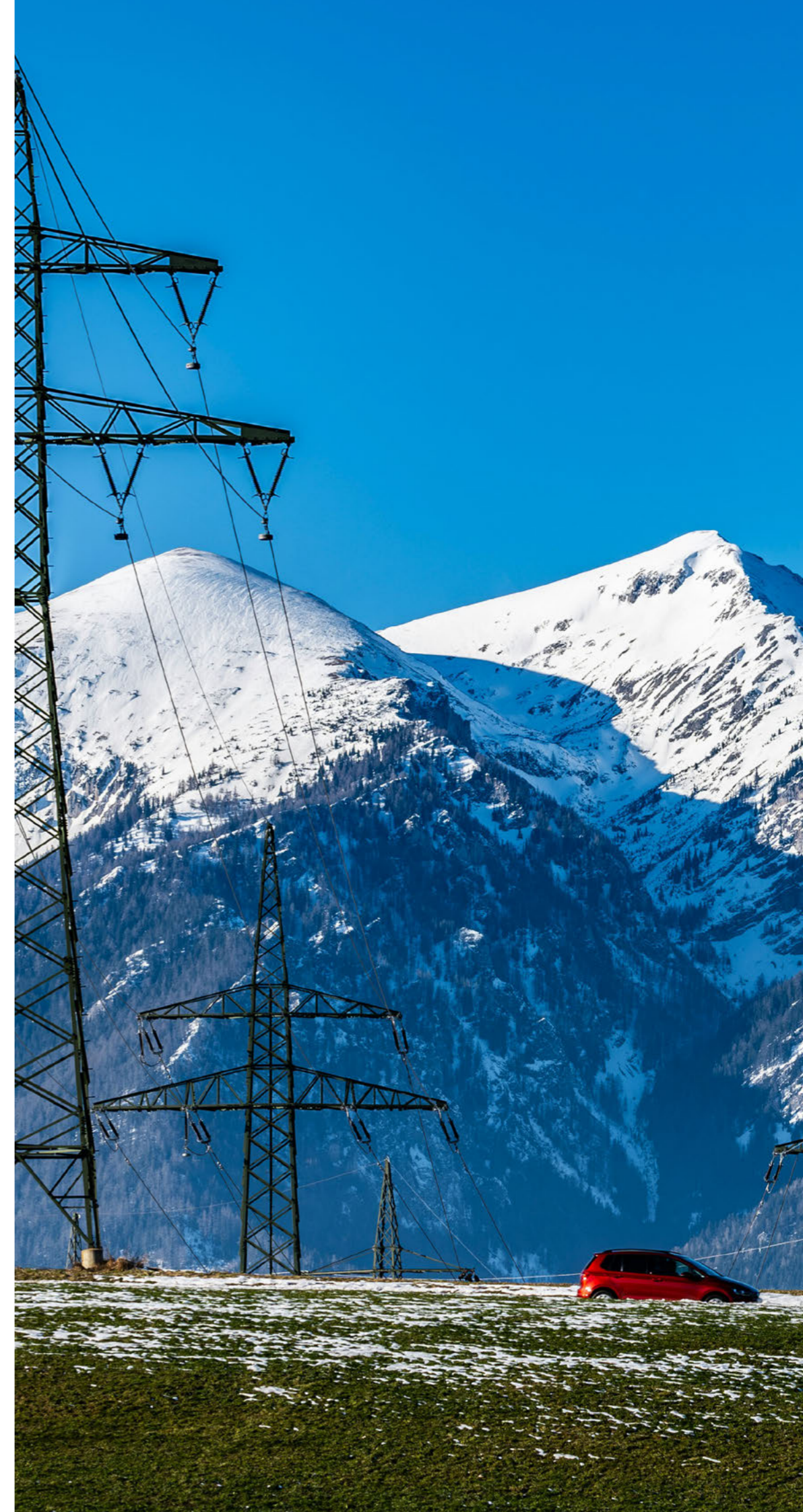
Hochspannungsleitungen in österreichischer Tallage in den Alpen
