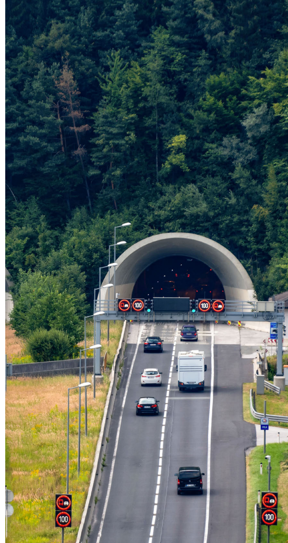
Tunneleinfahrt auf einer österreichischen Autobahn
